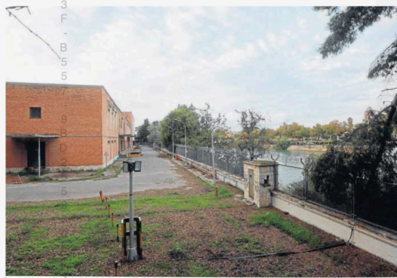
Estado actual de la zona más cercana al Guadalquivir.
